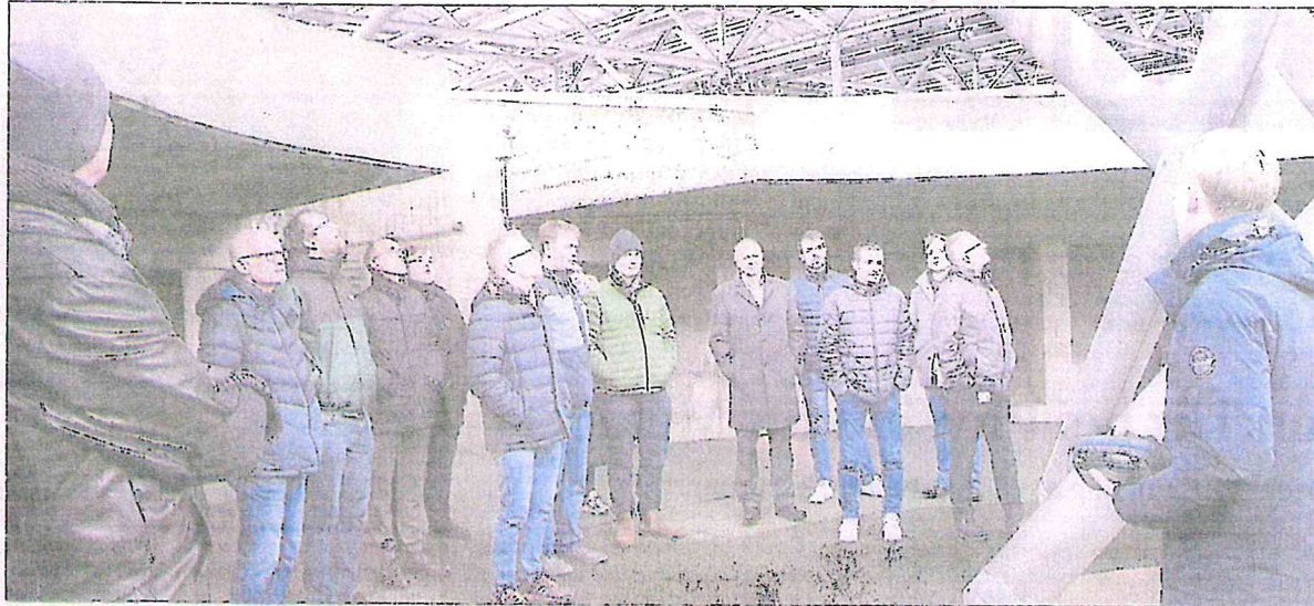
Auf dem Energiebunker Wilhelmsburg: Fabian Kneule (r.) von Hamburg Energie zeigt den Teilnehmern des Energieeffizienz- und Klimaschutz-Netzwerks Westküste die Solarthermie-Anlage. Foto: egw/Neumann
