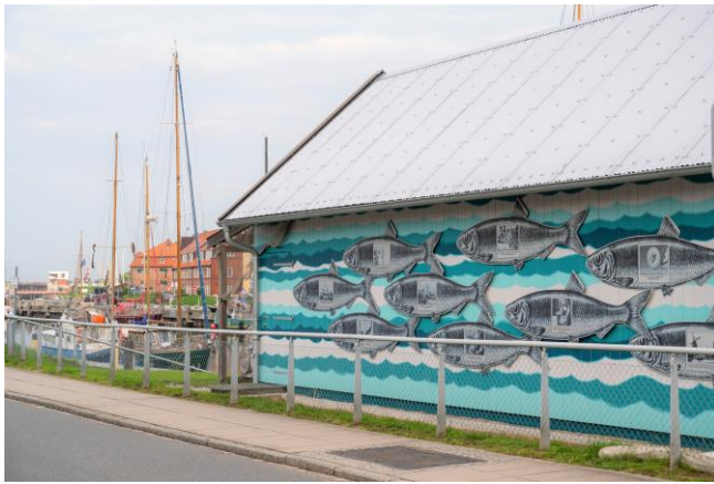
Projektbeispiel: Neubau eines Werftschuppens an der Slipanlage Glückstadt
